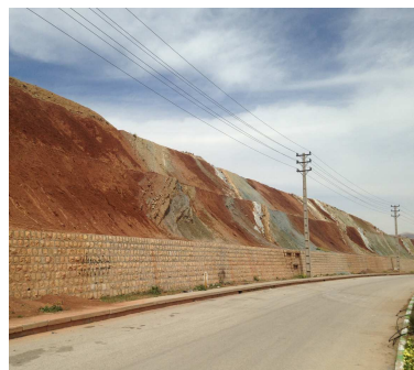
شکل ۱. وجود لایه‌های مختلف مارنی در یک محدوده - بزرگراه حسینی الهاشمی - شیراز.
