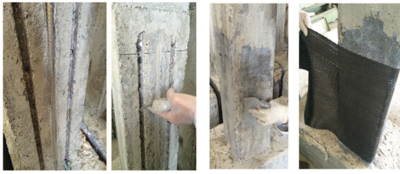
الف) مراحل تقویت به روش NSM؛ ب) مراحل محصور کردن ستون.
