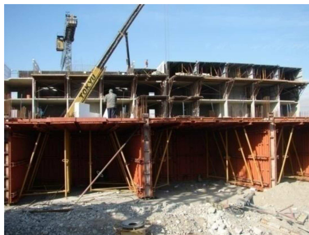
شکل ۱. قالب‌بندی ساختمان بتنی قالب‌تونی.
