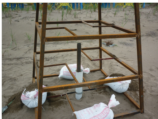
شکل ۷. هدایت لوله‌ی فولادی به درون غلاف.
