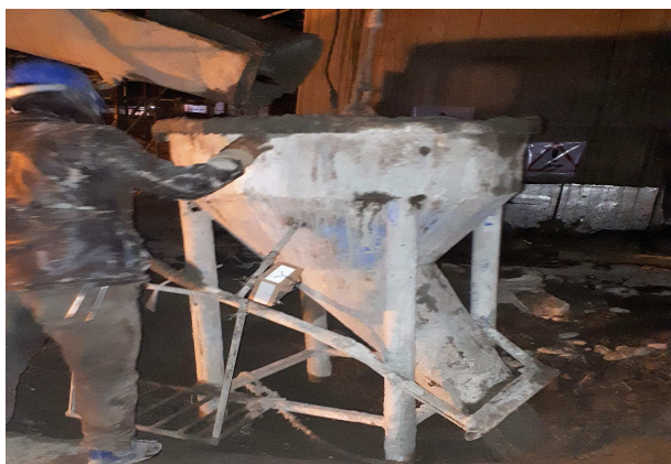
شکل ۱۵. نصب محفظه‌ی دوربین در جام بتن.
