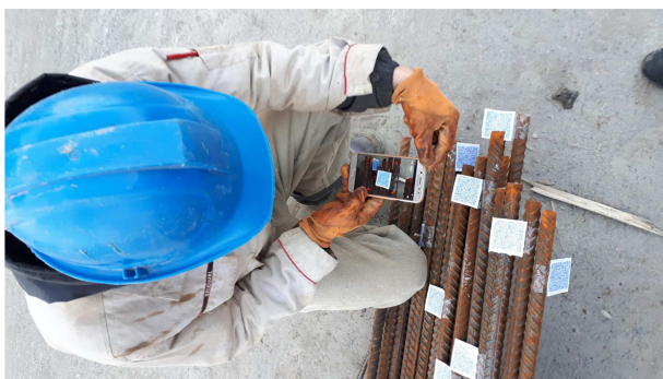
شکل ۷. عامل ساخت در حال استفاده از برچسب‌های QR Code.
