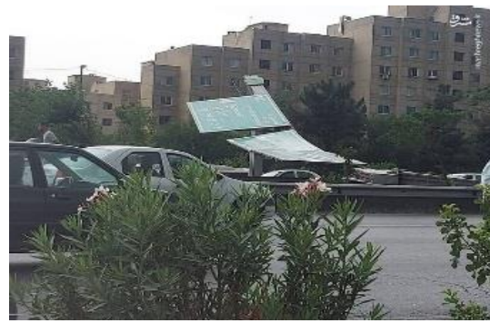
شکل ۱. نمایی از سقوط تابلوی مسیرنما در اثر ورزش باد.
