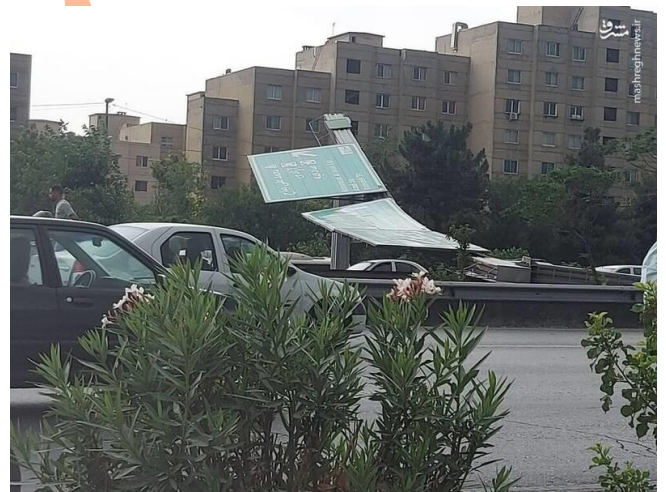
شکل ۱: نمایی از سقوط تابلو مسیرنا در اثر وزش باد
