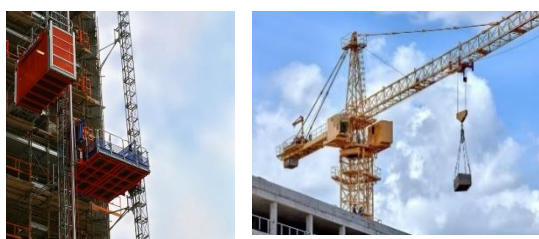
شکل ۱. جرتقیل و بالابر ساختمانی نصب‌شده در پروژه‌ی مطالعاتی.
