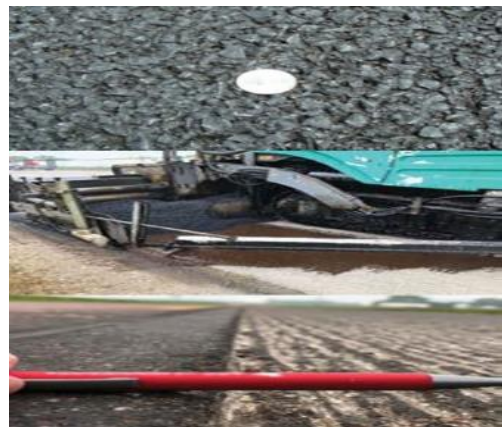
شکل ۲. سطح نهایی، عملیات اجرا، و نمای مقطع UTBWC (منبع: اداره‌ی حمل‌ونقل فدرال (FHWA) [۱] ، اداره‌ی حمل‌ونقل ایالت مینسوتا).
