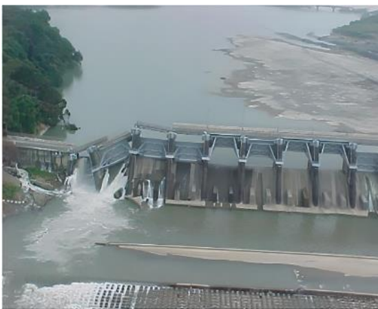
شکل ۸. تخریب سرریز بلوک‌های ۱۶ تا ۱۸ سد شی‌کانگ ناشی از زلزله‌ی چیچی در سال ۱۹۹۹.
