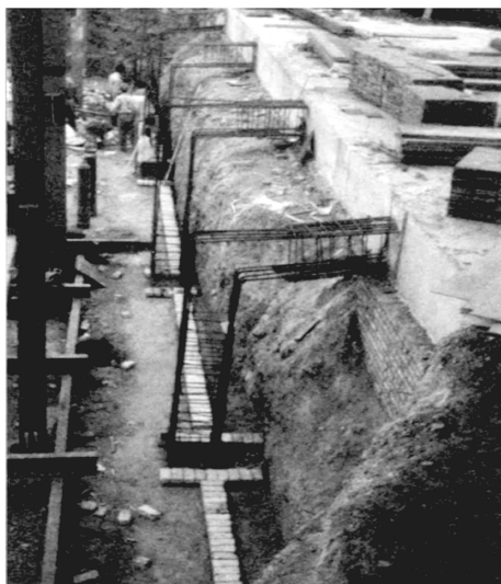
شکل ۴. اتصال دو پی با اختلاف تراز برای \alpha > 15 . [۴]
