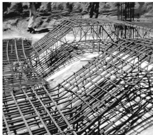
شکل ۳. اتصال غلط دو پی با اختلاف تراز برای \alpha > 15 . [۴]
