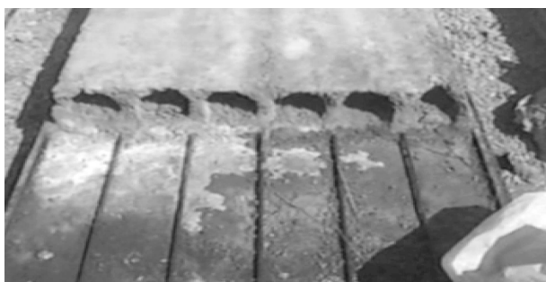
الف) نمای نزدیک از دال‌های مجوف بتنی (بتن معمولی) پس از اجرای عملیات جک‌زدن، بتن‌ریزی و قبل از تیندن دال؛
