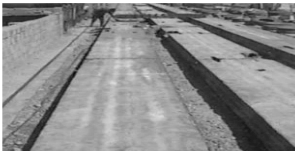
ب) نمایی از بستر دال‌های مجوف بتنی (بتن معمولی) پس از عملیات جک‌زدن، بتن‌ریزی و قبل از تیندن دال.
