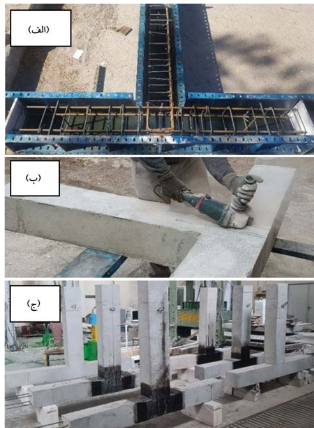
شکل ۱۲. الف) آرماتوربندی و قالب‌بندی، ب) شیارزنی جهت اجرای طرح تقویت به روش NSM، ج) نصب الیاف CFRP.
